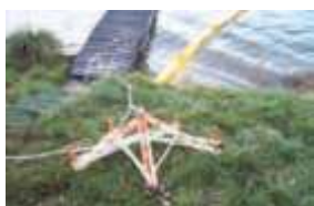
Système d'ancrage sur berge
